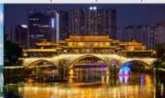
สะพานอันชุน
